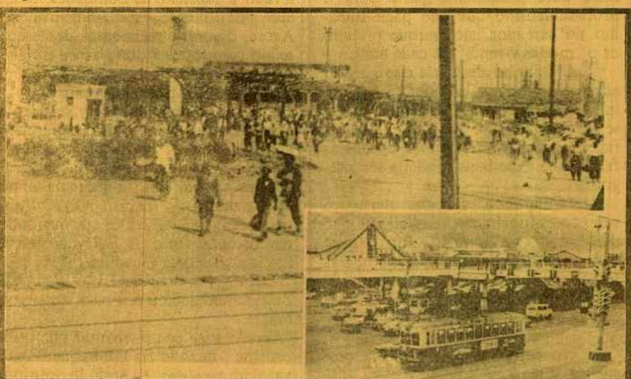
A estação rodoviária depois da bomba e, em baixo hoje já reconstruída.
