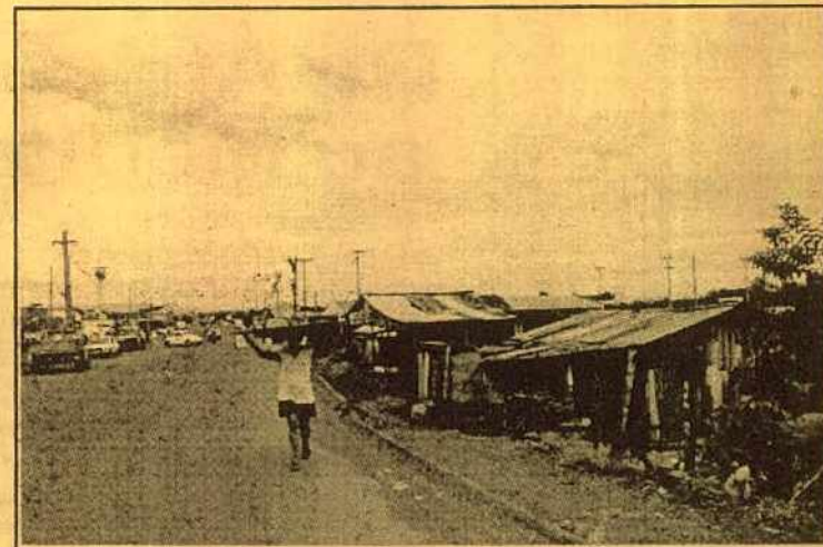
... prossegue na favela em construção...
