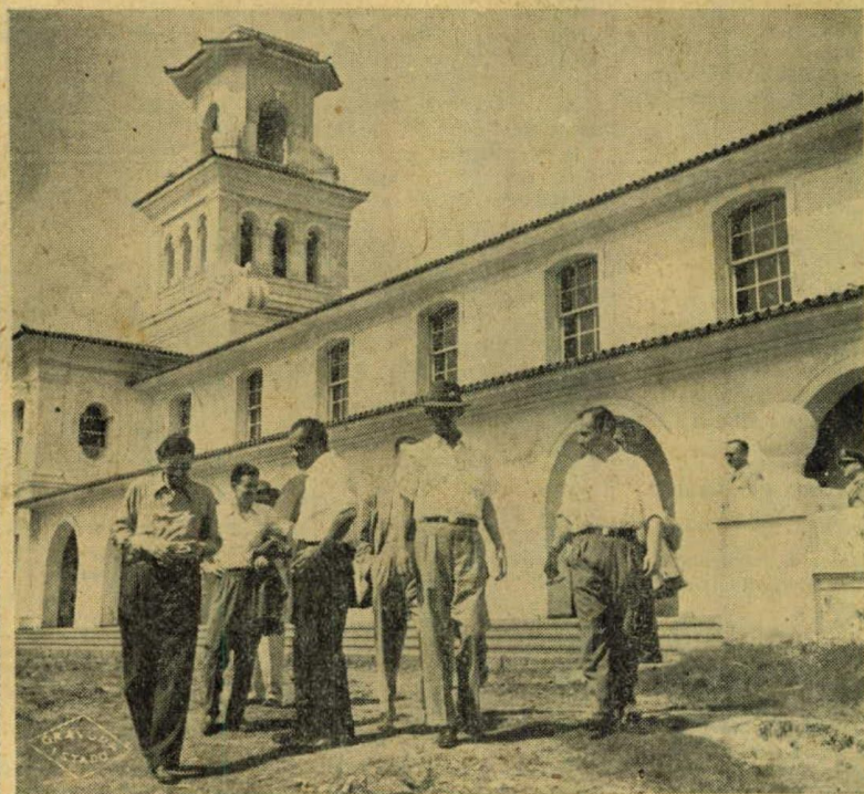
O Ministro Costa Pôrto e o Governador Munhoz da Rocha quando inspecionavam as obras do Hotel de Foz do Iguaçu praticamente concluídas.
