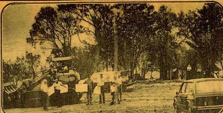
Neste local se constrói a sede do Cataratas Iate Clube, às margens do Rio Paraná, sob a orientação de Casemiro Domareski e Sergio Lobato Machado, dois grandes homens de empresa.
