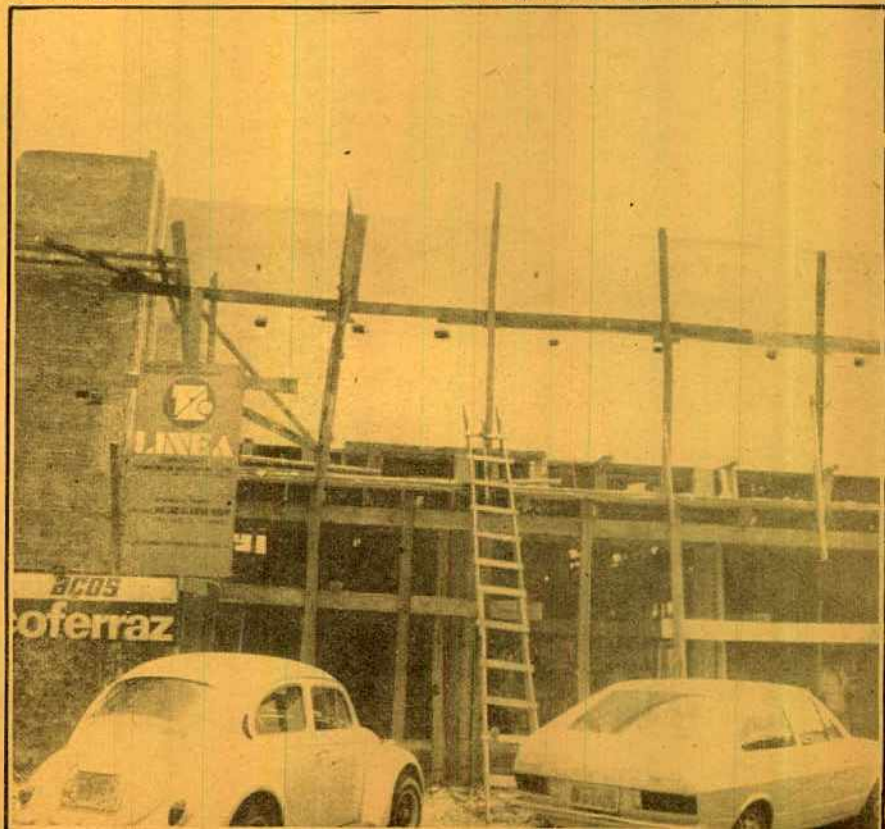
Copeçal: dentro de 30 dias funcionando à todo vapor
