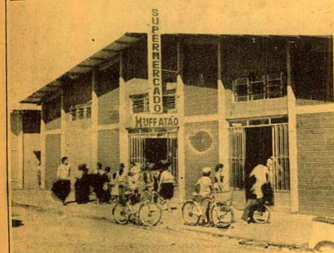
Edificado em linhas próprias à Itaipu, o novo Muffatão está na Vila C, bem junto a barragem da Usina.
