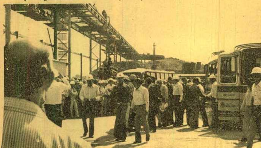
Figueiredo e Costa Cavalcanti, durante a visita ao Canteiro de Obras.
