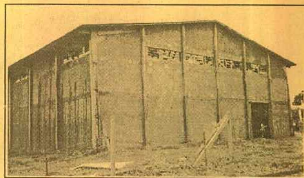
O galpão da Umamfi: depredação e abandono
