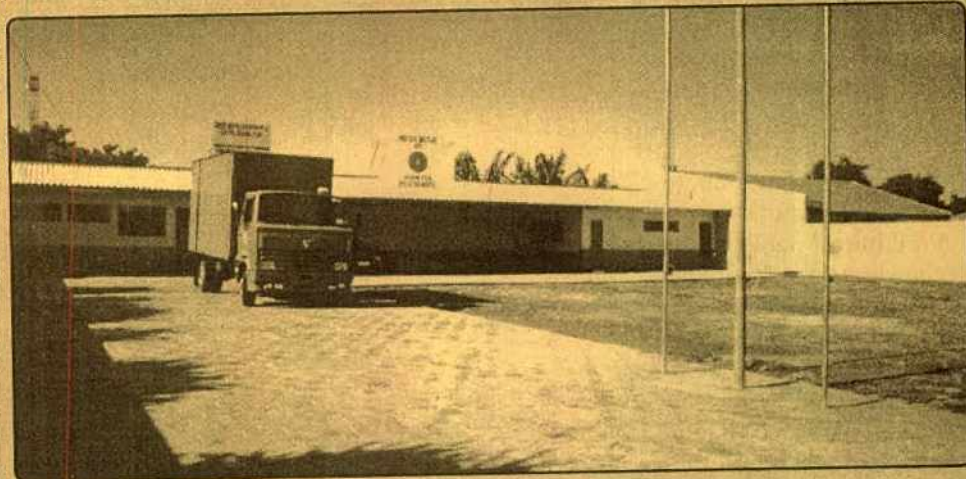
O Destacamento da PM, embora não concluído, funciona
