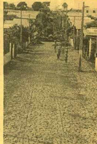
Calçamento da Vila Miranda em obras
