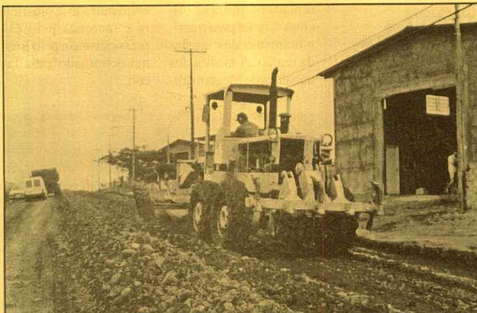
Em obras, novo acesso aos bairros Três Bandeiras, Plaza Foz e Nacional
