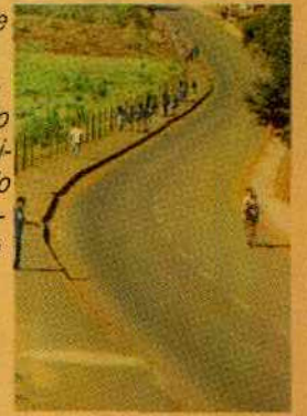
Asfalto na Avenida Angela Aparecida de Andrade
