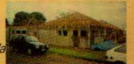
Sete creches e oito postos de saúde em construção
