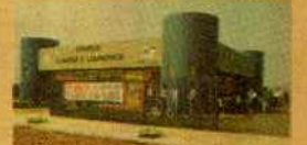
Construção da Creche Claudio S. Lourenço, no Sol de Maio
