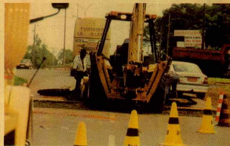
Ruas e avenidas estão sendo reparadas em toda a cidade
