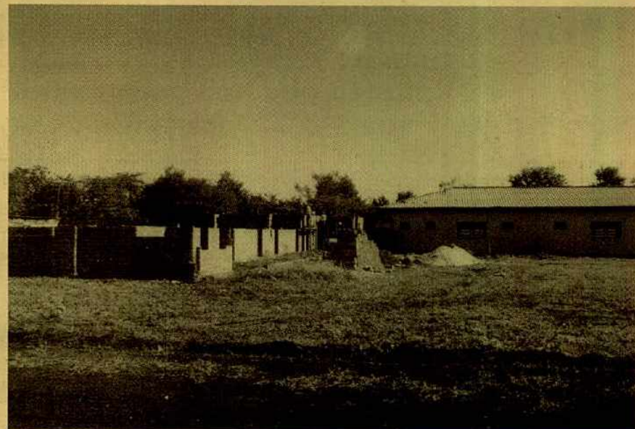
Novo pavilhão do Posto de Saúde em construção
