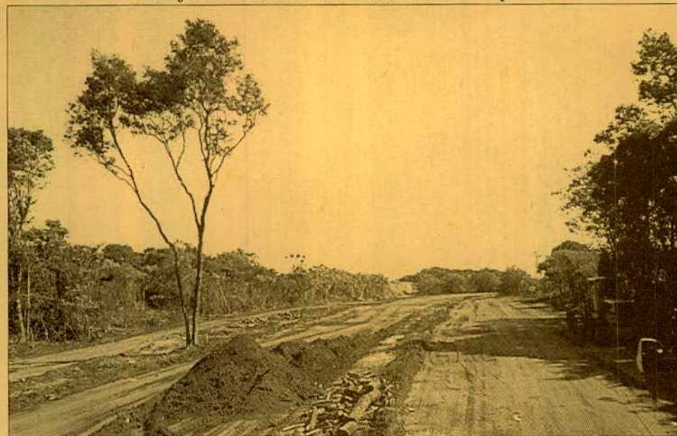
Trecho é de pouco mais de 1km e 32.344,70m 2 de asfalto
