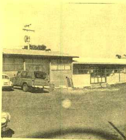
PRÉDIO ASSESSORIA DE PLANEJAMENTO
