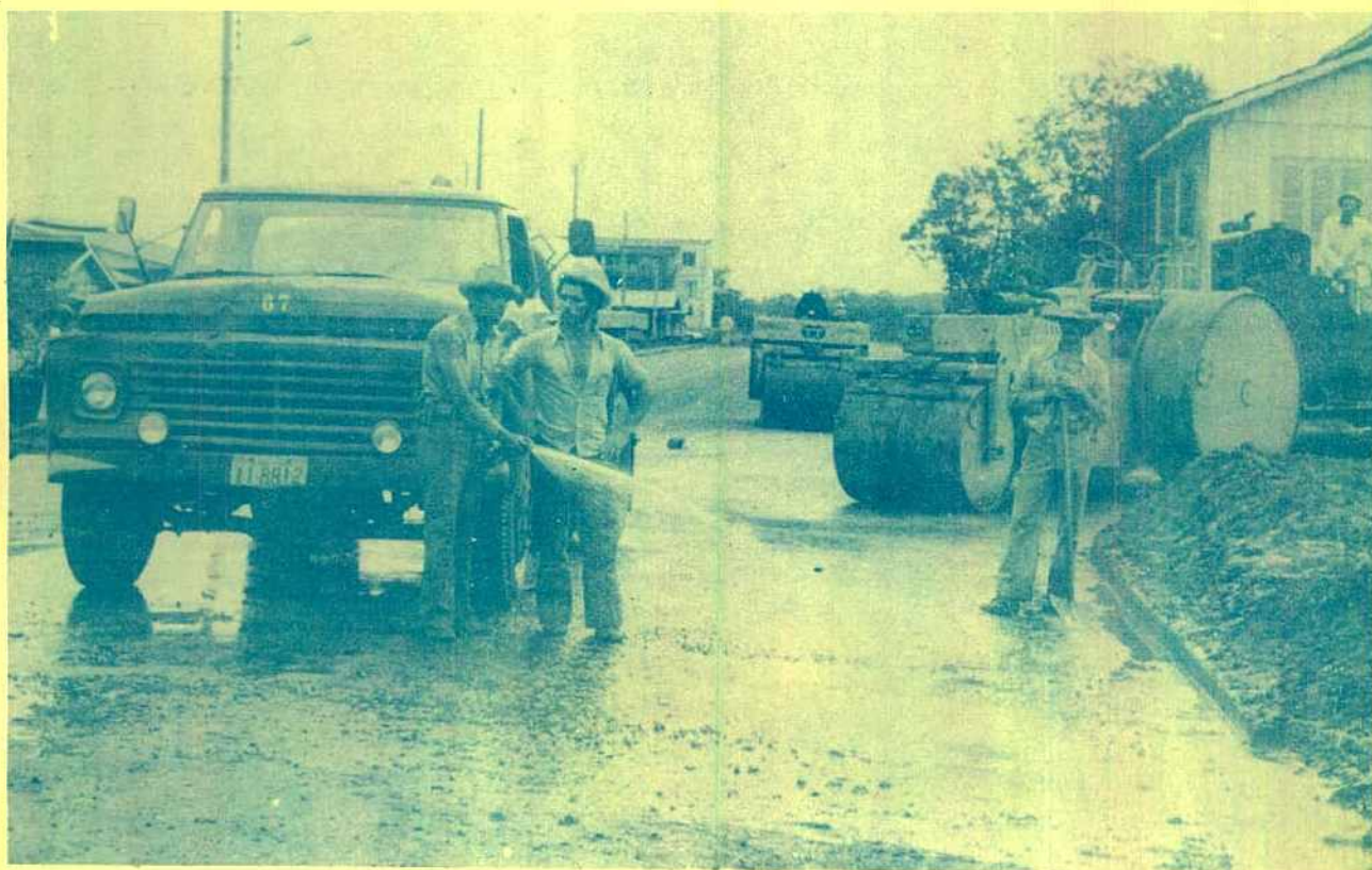
asfalto em ritmo acelerado
