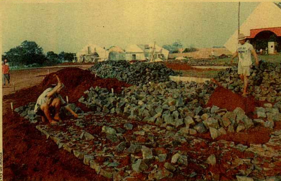
Obras em andamento
