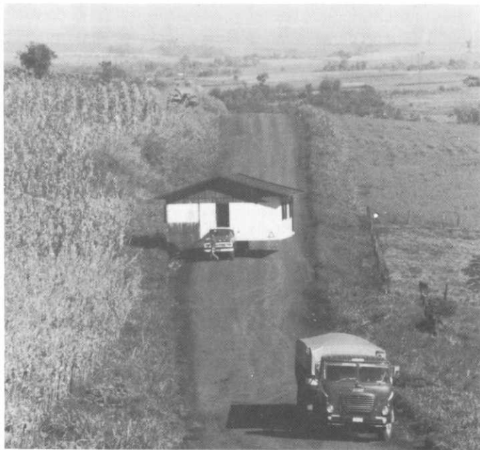
Uma casa sendo transportada do local onde as águas do reservatório encobriram, em meados de 1982.
