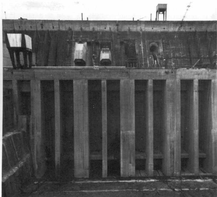
Casa de força do canal de desvio, obra iniciada na gestão de Ney Braga.
