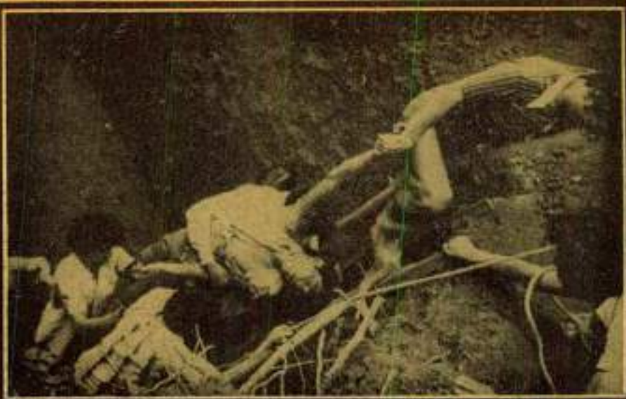
O operário sendo retirado do poço, já sem vida, com auxílio de cordas e escadas.
