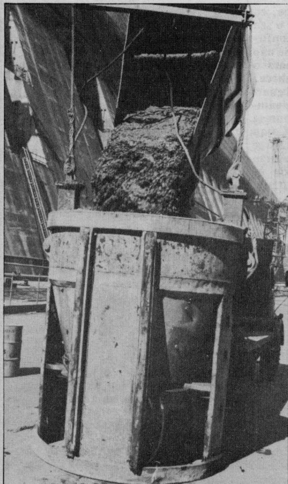
Mesmo com as dificuldades naturais, parte do concreto da Casa de força é lançada pelos guindastes.
