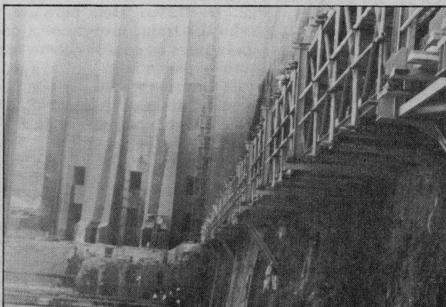
A passarela em estrutura metálica facilitará o acesso do pessoal às frentes de serviço, sobretudo do Eixo A/B.
