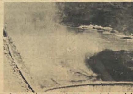
Las aguas irrumpen estruendosamente, luego de la detonación, hasta ser contenidas por el dique de jusante.
