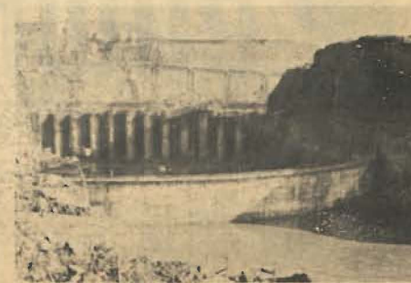
Aspecto da entrada do Canal, em Montante, com as águas contidas pelo Arco e nivelando-se ao espelho das águas do rio.
