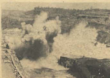
Um... dois... três... fogo. A detonação rompe o septo de jusante para dar entrada às águas até o Arco.
