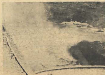
As águas avançam até a Ensecadeira em Arco de Jusante, antes mesmo do pó, da fumaça e da água se assentarem.
