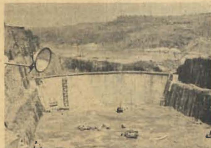
Aspecto del muro de jusante — detrás del arco — minutos antes de ser detonado.
