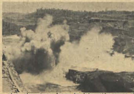
Una... dos... tres... fuego. La detonación rompe el muro natural del río para dar entrada a las aguas hasta el arco de contención.
