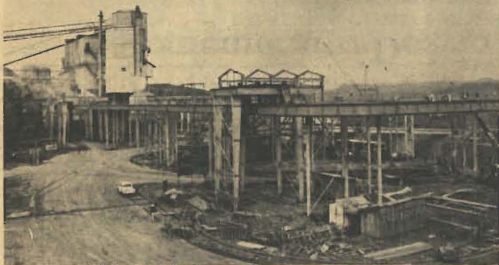
Vista general de la Fase A de las Monovías, ya en etapa de conclusión.
