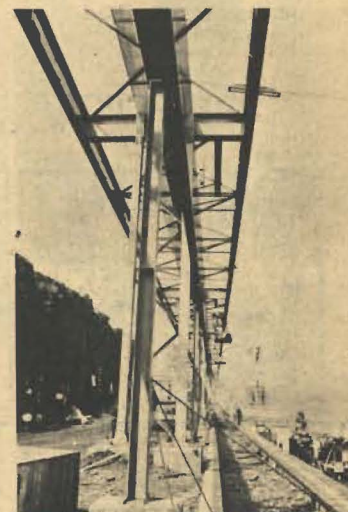
La foto muestra los rieles de los carritos de transferencia.
