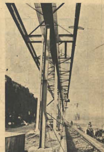
A foto mostra os trilhos dos carrinhos de transferência.
