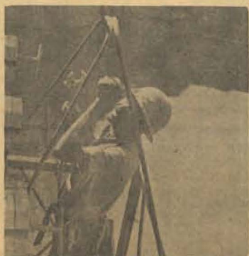
Trabalhando suspenso sobre o canal de desvio.
