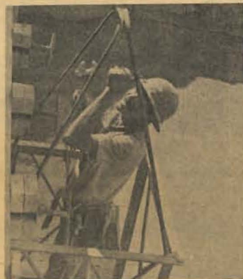
Trabajando, suspendido, sobre el canal de desvío.
