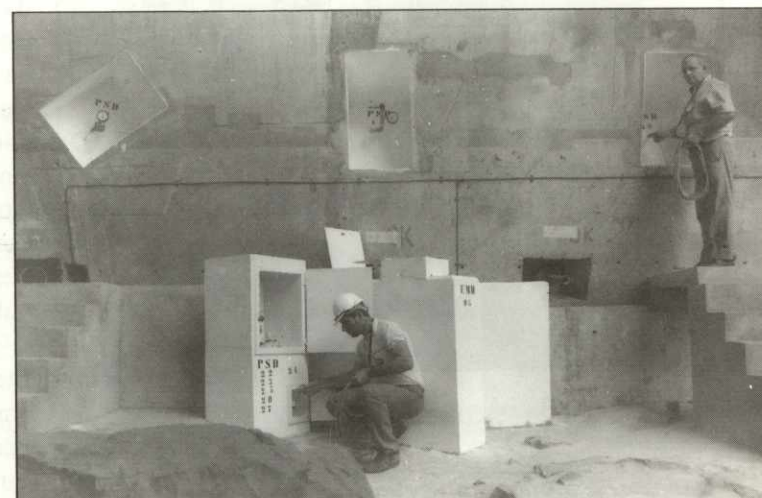
Leituristas fazem, mensalmente, a obtenção de dados do piezômetro, instrumento que mede o nível da água nas fundações da barragem.
