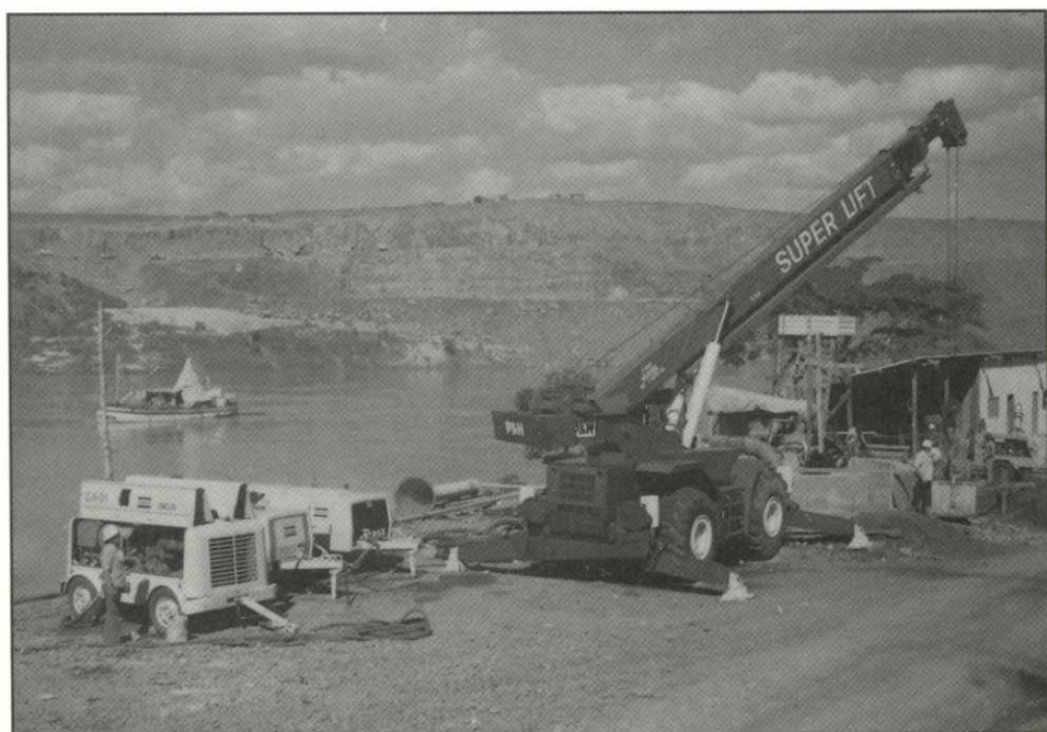
Boca do grande poço, durante a época de escavação.
