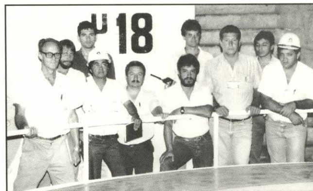
1991. Instalação da 18.ª e última unidade. Sato é o terceiro à esquerda, de óculos e capacete.
