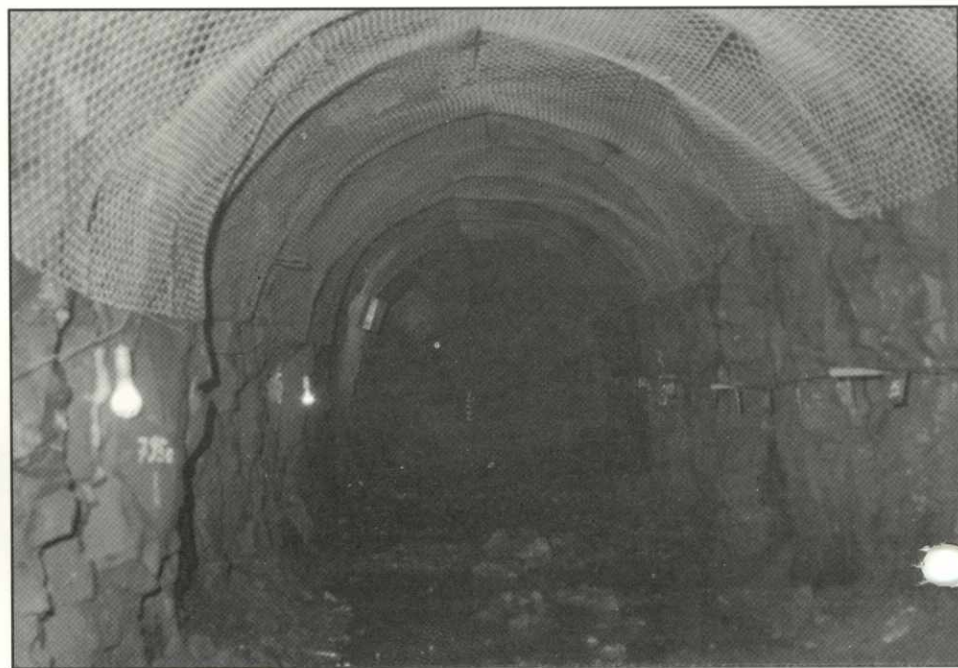
Interior do túnel de investigação de brechas.
