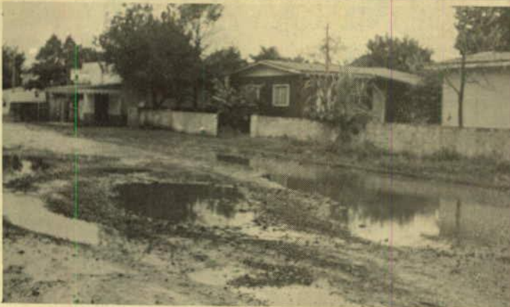
Vila Yolanda, em frente ao Estádio Pedro Basso: não existem calçadas, e os buracos da rua (vários) ficaram alagados
