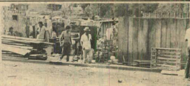
Casas em construção para favelados
