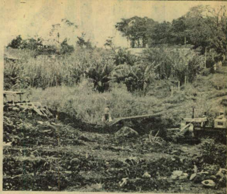
Codefi abrindo ruas e construindo bueiros
