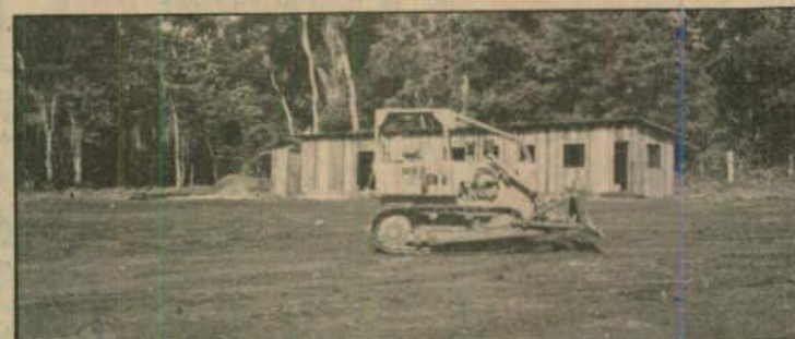
Começaram os trabalhos de terraplanagem e depósitos de materiais foram levantados no local
