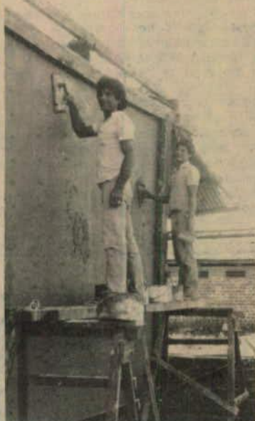
As obras continuam e o galpão do restaurante está em fase final.
