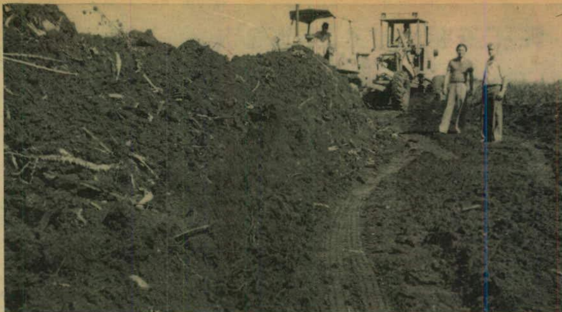
O agrônomo da Itaipu Binacional Oscar Darlan Ferreira (à esquerda) e o Prefeito de São Miguel do Iguaçu, Armando Luiz Polita, inspecionam a formação de murunduns para a conservação de solos
