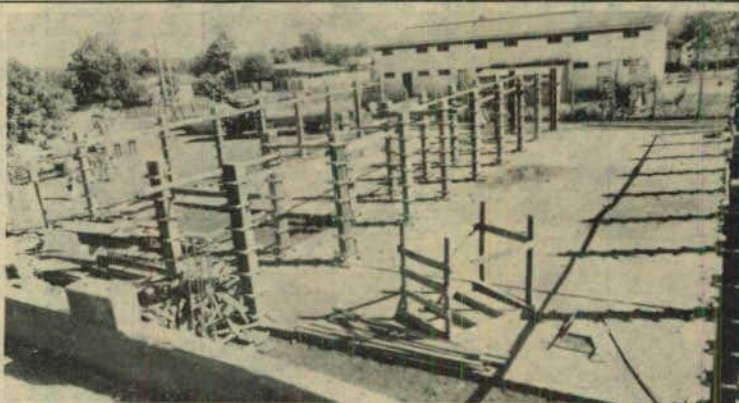
Obras na Escola Acácio Pedroso
