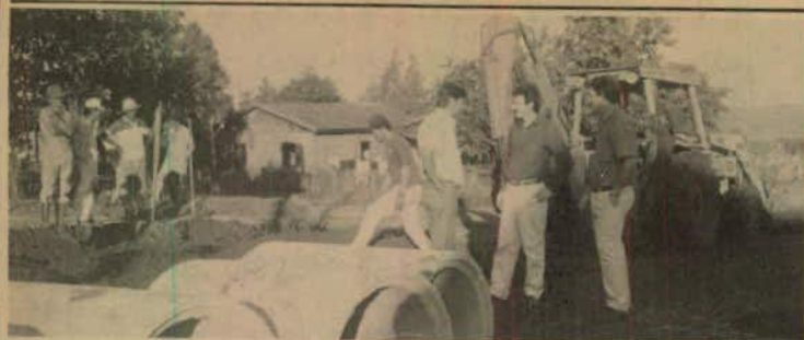
Colocação de tubos nas galerias pluviais. Prefeito Carlos Montemezzo, Pedro Nandi, vice-prefeito e João Jacinto.
