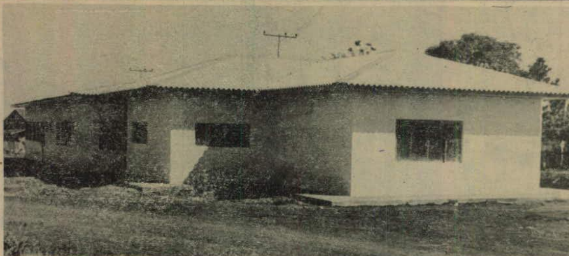
Mini-hospital de Juvinópolis, em fase de conclusão
