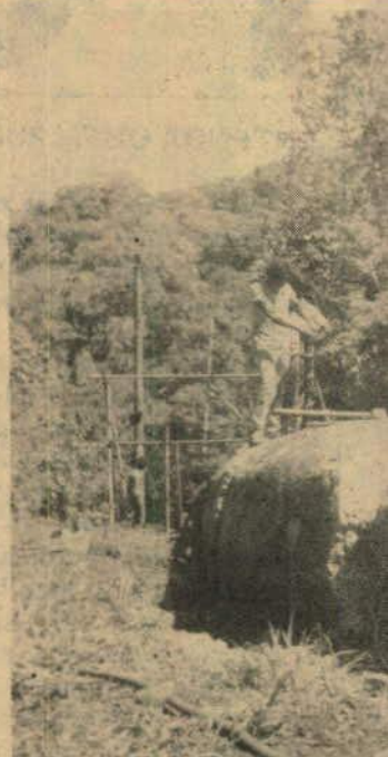
Tubulação de concreto: substituir para preservar do original.
