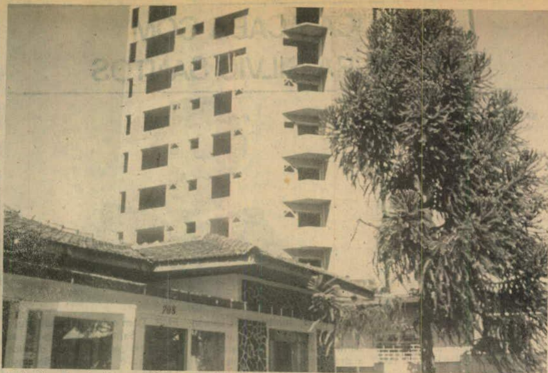
Telhados são atingidos por objetos que despenham da construção
