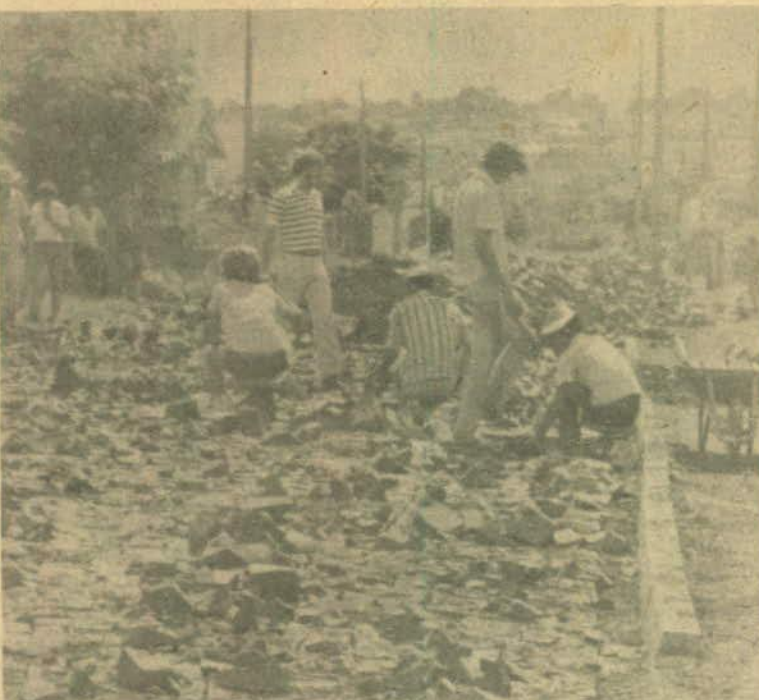
Dr. Celso faz a vistoria das obras.
