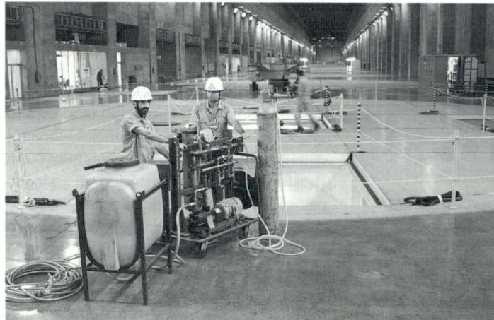
O "Siate" em ação: técnicos de Manutenção Mecânica fazem a limpeza dos condutores ocultos das barras estatóricas. A dupla é Ademair Pereira e Luciano Castro Lopes. Na outra foto, Ronaldo Dorneles Duarte.
