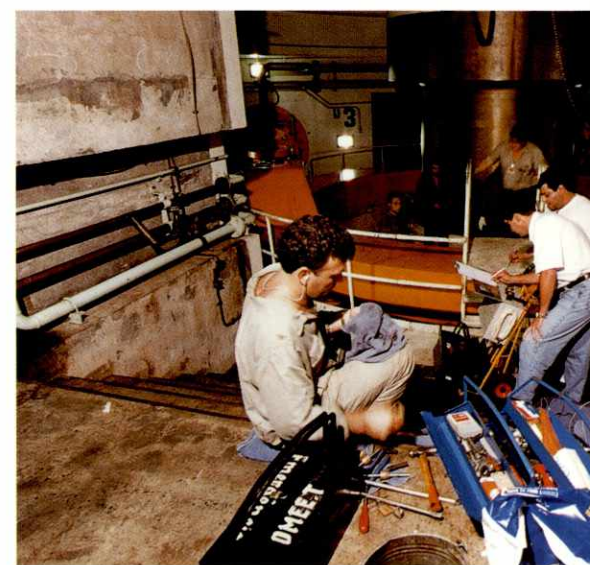
Trabalhando contra o relógio, técnicos de Itaipu antecipam o programa de manutenção da Unidade 3.
