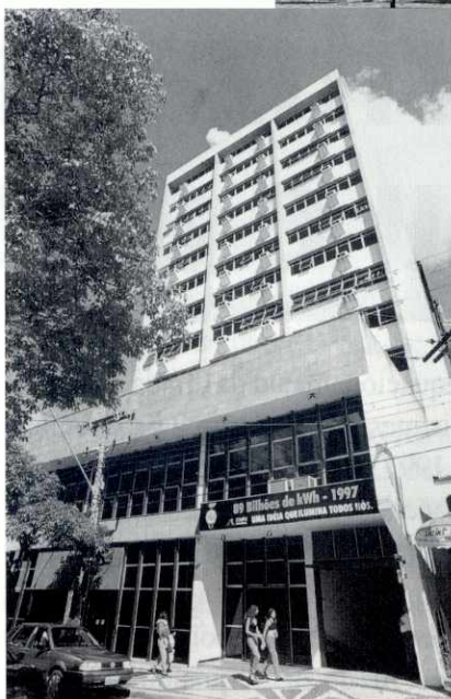
No Edifício Parigot de Souza, em Curitiba, um adesivo na fachada registrou o recorde.
