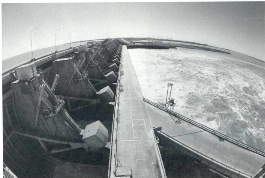
A Usina de Yacyretá, construída por argentinos e paraguaios a 300 km de Itaipu.
