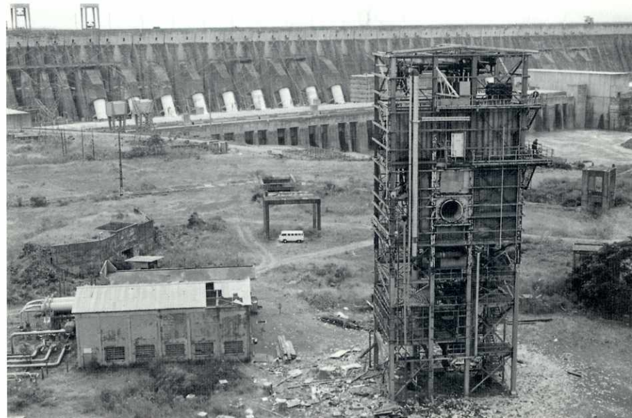
A torre e uma das centrais de refrigeração: gigantescos remanescentes da época das obras na Usina.
