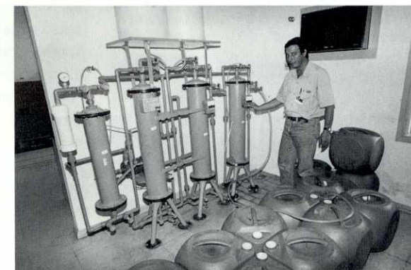
Higinio Gonzales Corvalan, auxiliar técnico, acompanha a captação e a filtragem da água, que é armazenada em tambores.
