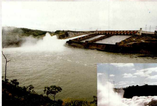
O vertedouro em duas versões: só com uma calha aberta, em 26 de setembro de 1997, e em 28 de abril deste ano, jorrando 12 mil metros cúbicos de água por segundo.
