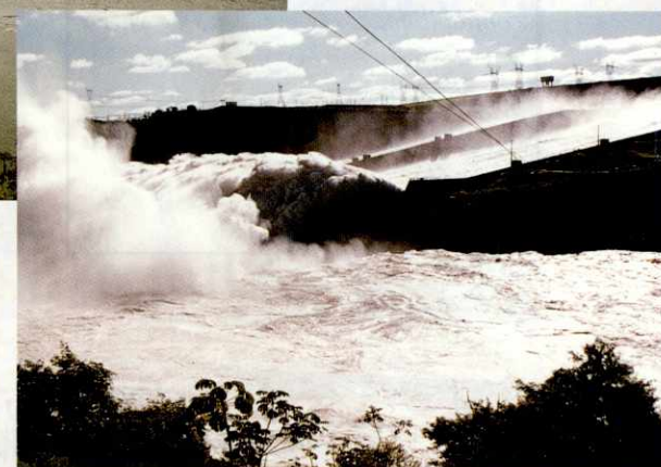
O vertedouro em duas versões: só com uma calha aberta, em 26 de setembro de 1997, e em 28 de abril deste ano, jorrando 12 mil metros cúbicos de água por segundo.
