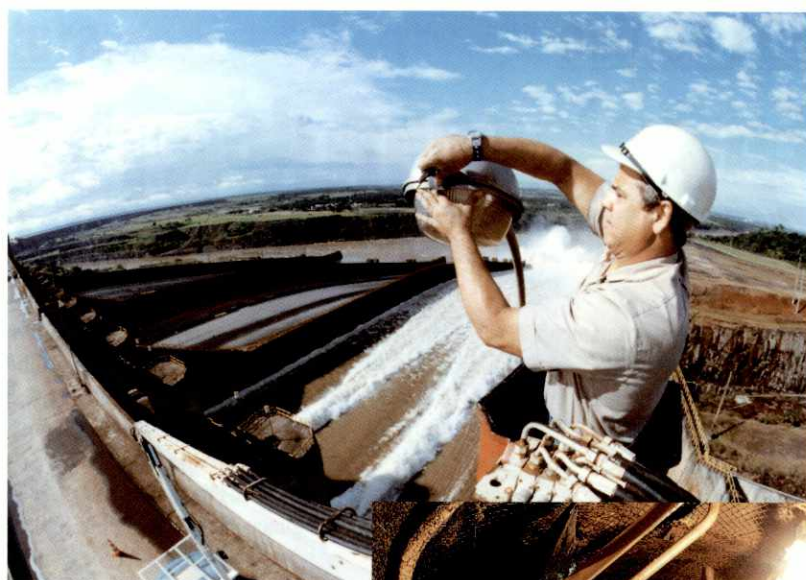
Elizio Pereira da Silva sobre o vertedouro: para algumas pessoas, sensação de vertigem.
