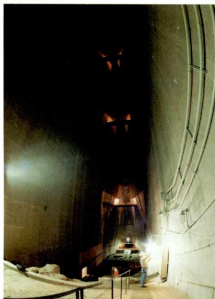
Na cota 56, sensação de solidão no gigantismo da galeria.
