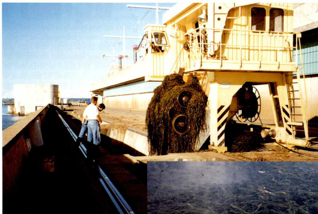
Em Jupia, um guindaste retira das águas do reservatório 60 metros cúbicos de planta por dia.
