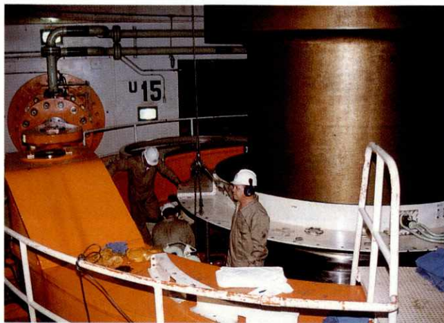
Jair Martello supervisiona o levantamento da tampa do mancal-guia da turbina.
