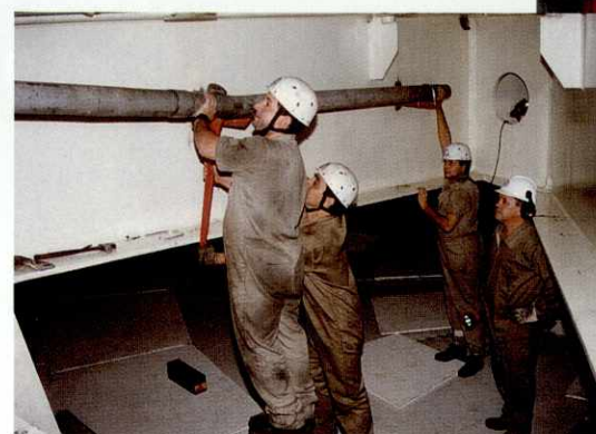
Por essa tubulação vão passar os instrumentos do Mondig no mancal-guia superior. Na foto, Assis dos Santos, Dinisio Lopez e Hugo Veron fazem a montagem, sob a supervisão de Jair Martello.
