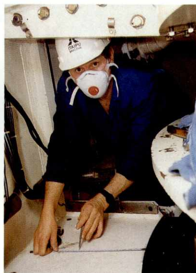
Pedro Olian faz preparativos para a instalação de instrumentos no mancal-guia superior.
