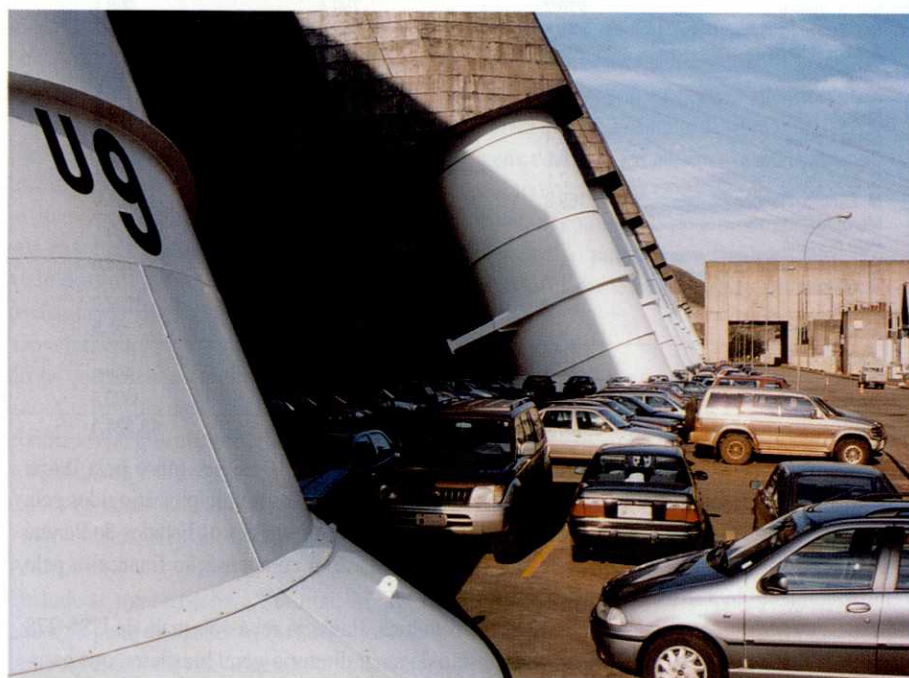
Estacionamento na área do Edifício da Produção: congestionamento.
