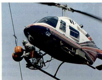
Com as linhas energizadas, a substituição de componentes danificados.
