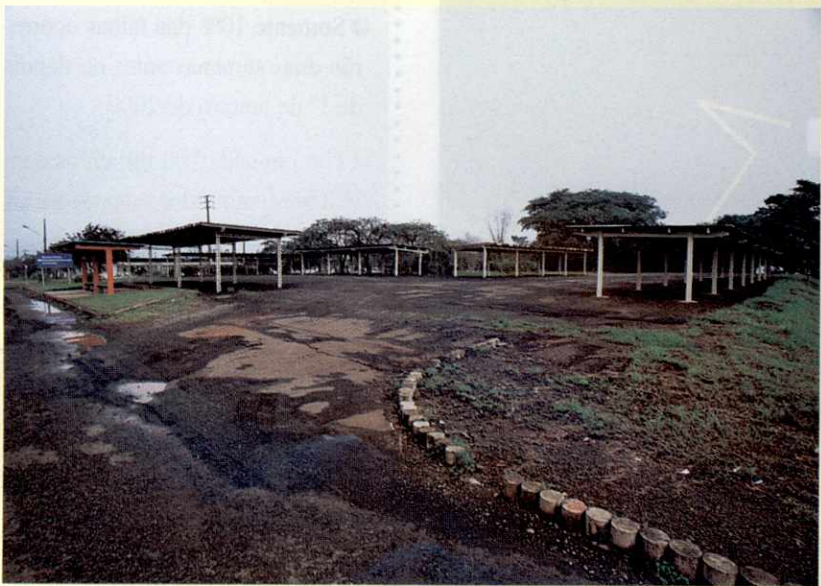
Este é o novo estacionamento, que começa a operar em 1º de agosto.
