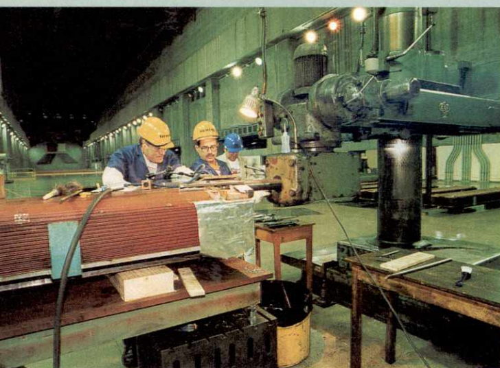
Depois de marcar um local específico, os técnicos furam os pólos do gerador: seis furos em uma extremidade e dois em outra.
