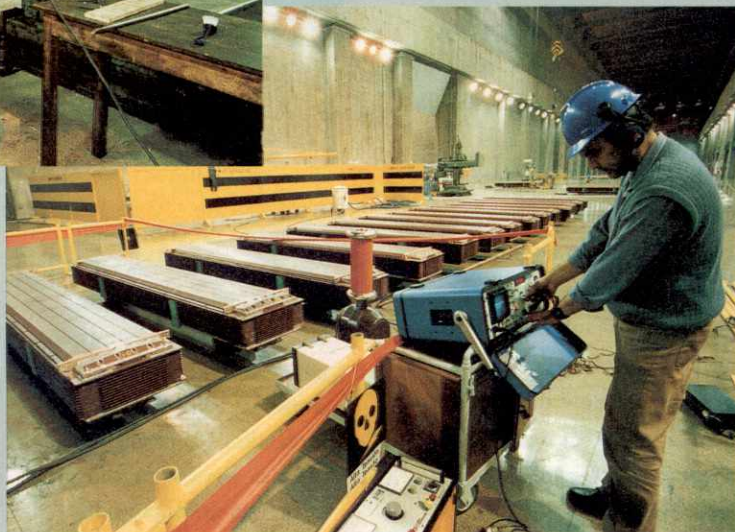
Final: o técnico Jaci Florêncio de Souza faz ensaios elétricos nos pólos reparados.
