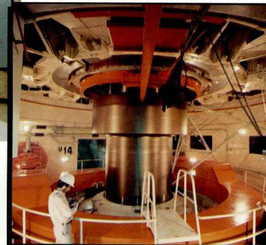
A operação a plena carga é acompanhada da Sala de Despacho de Carga, que entre suas principais funções controla o intercâmbio de energia com as empresas interligadas. Cada turbina, com capacidade para produzir 700 MW, está gerando até 730 MW de energia.
