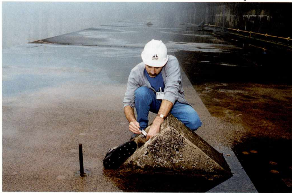
Em locais escorregadios, os técnicos contam com botinas especiais criadas por um empregado. Páginas 8 e 9
